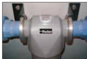
Zestaw wsporników do montażu naściennego Wsporniki dodatkowo mocują filtry zainstalowane w układach z elastycznymi przewodami rurowymi lub w urządzeniach producentów oryginalnego sprzętu (OEM).
